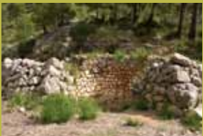
Forns de calç des comellar de sa Cova Rotja
